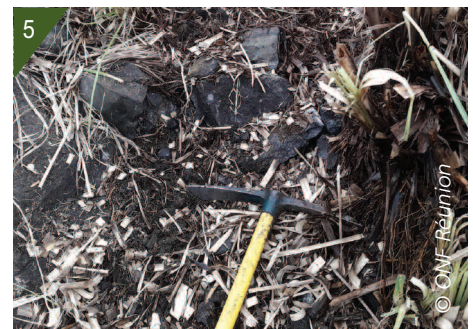
3 et 4 - Arrachage de l'Herbe de la Pampa. 5 - Pioche utilisée pour le dessouchage.
