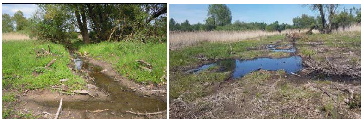
Figure 10b : Travaux de réouverture d'un marais créant des habitats favorables pour B. bombina . Photos : Myriam POULLARD.
