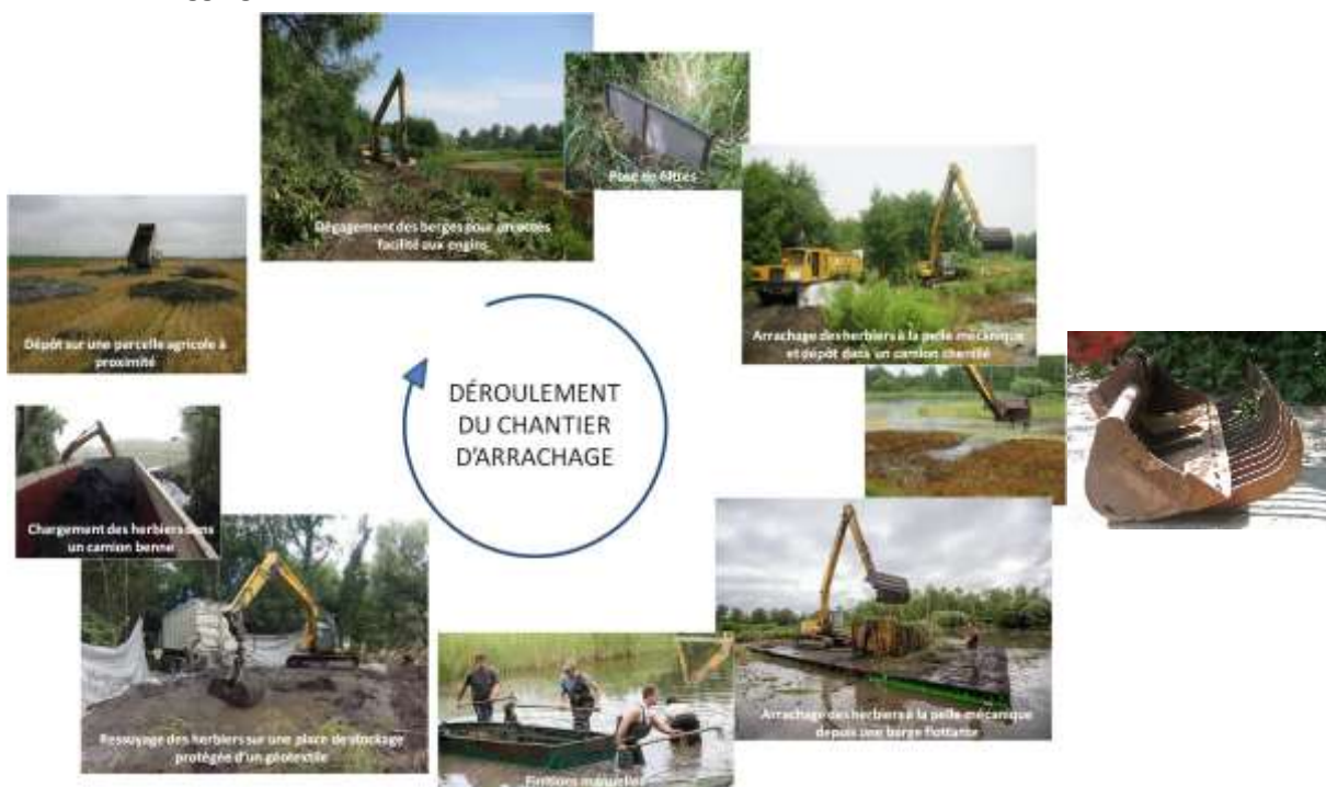
Figure 4 : Déroulement du chantier d'arrachage mécanique en 2013 – Different stages of the mechanical digging in 2013
