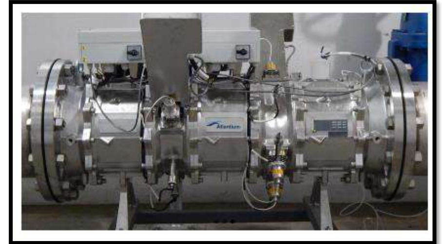
Système de désinfection hydro-optique – Barrage Davis (Pucherelli et Claudi., 2017)
