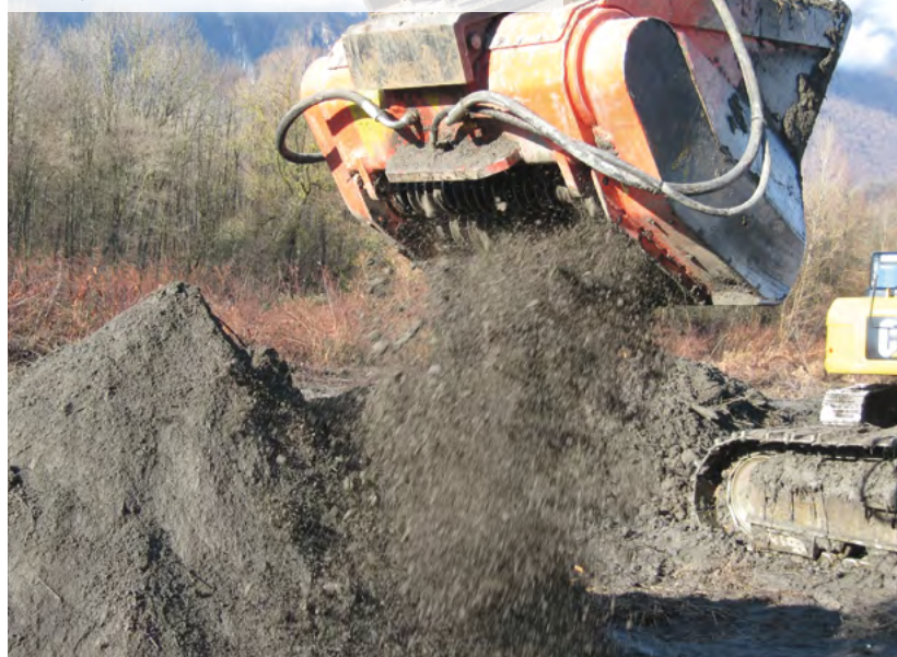
Godet concasseur utilisé pour le traitement de renouées asiatiques sur un chantier en Isère. © Aquabio
