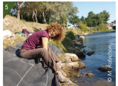
5 - Mise en place de la bâche.
