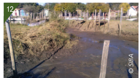
9 - Zone de déchargement et de ressuyage des déchets issus de l'intervention. 10, 11 et 12 - Herbage de jussie à marée haute (10), à marée basse (11) et après interventions d'arrachage (12).
