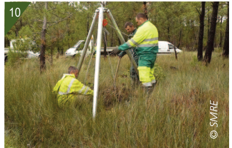
7- Plaques couvre-sol pour limiter la dégradation du pré salé lors des interventions d'arrachage mécanique. 8 et 9- Chantier d'arrachage réalisé par des bénévoles. 10- Chèvre-trépid de levage télescopique.
