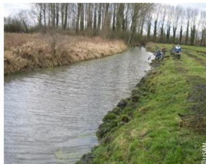
Un secteur après interventions
