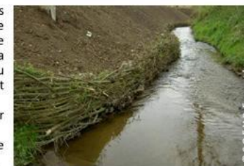
Pose des Saules tressés en bordure de berges
