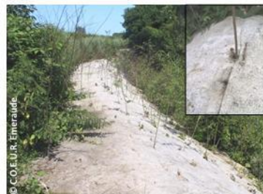
Zone bâchée avec boutures de Saules plantées
