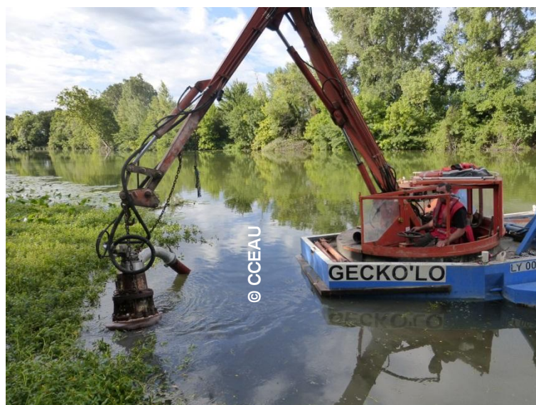
Figure 3 : travaux de gestion des jussies de 2014 (enlèvement manuel et par hydrocurage)
