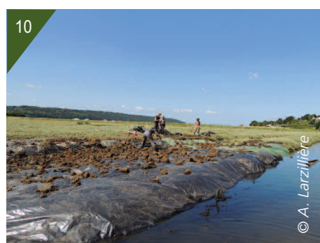
9 et 10. Pose de bâches.
