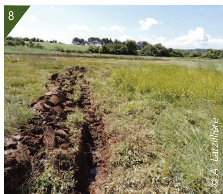
5, 6, 7 et 8. Creusement d'une tranchée.
