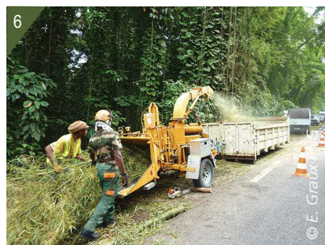
3 - Touffe de bambou avant abattage. 4 - Abattage des cannes. 5 - Ébranchage des cannes à la tronçonneuse. 6 - Broyage des branches en bord de route.
