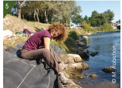
5 - Mise en place de la bâche.
