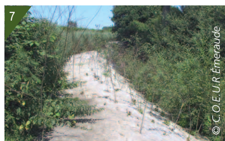
2- 3- Site d'intervention à différents stades de colonisation et d'intervention. 4- Site après arrachage manuel. 5- Pose des saules tressés en bordure de berges. 6- Zone bâchée. 7- Zone bâchée avec boutures de saules plantées.
