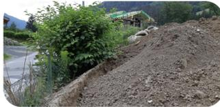
Stockage de matériaux sans précaution sur un massif de remblai - photo ©Aquadis
