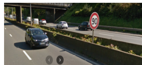
③ Tronçon de l'A6 fonctionnel et sécurisé avant le développement de l'Ailante glanduleux
