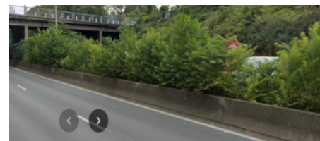
④ Tronçon de l'A6 non sécurisé après le développement de l'Ailante glanduleux
