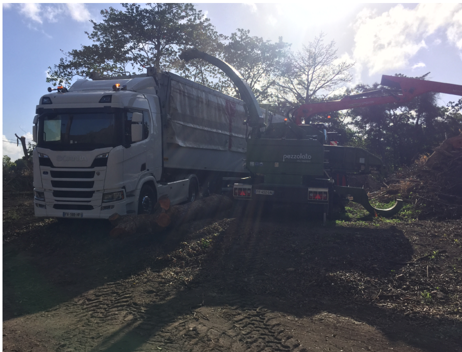
③ Broyage du Bambou le long de la ripisylve
