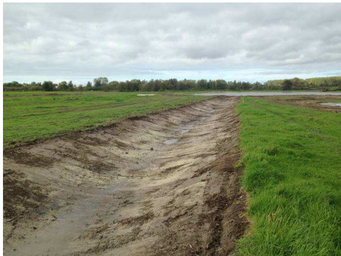
Curage des fossés
